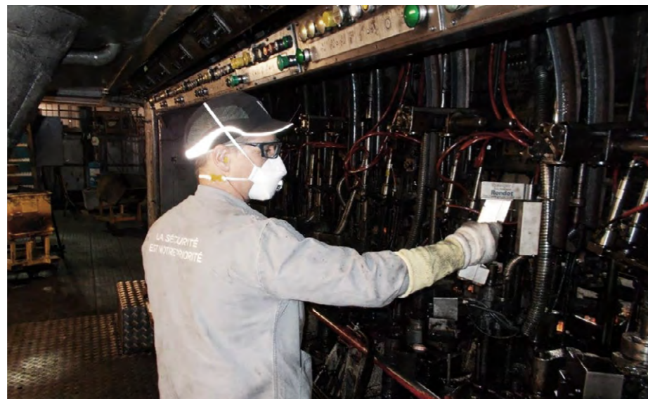
Verescence Mers-les-Bains, France
