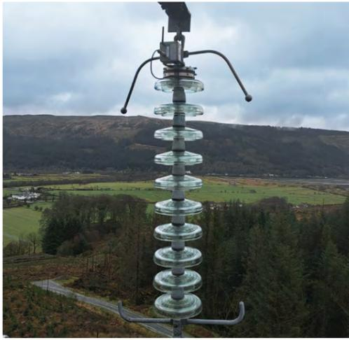
Sur notre site espagnol, nous produisons des isolateurs en verre, des pièces isolantes en forme de « disque » utilisées sur les lignes à haute tension. Afin d'aider nos clients à réduire les émissions de CO2 et les surcoûts liés à des opérations de nettoyage trop fréquentes ou à des contournements électriques survenus par un manque de maintenance,
